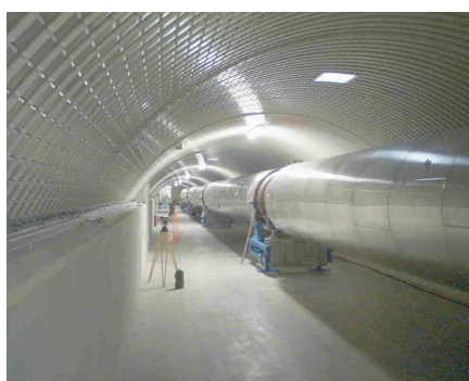
Il tubo da vuoto da 3 km in direzione Nord dell'interferometro per la rivelazione delle onde gravitazionali installato a Cascina (Pisa –Italia).
